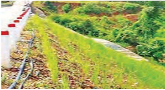
Hình 4. Trồng Vetiver gia cố taluy âm cầu A Vương, huyện Tây Giang, tỉnh Quảng Nam [7]
