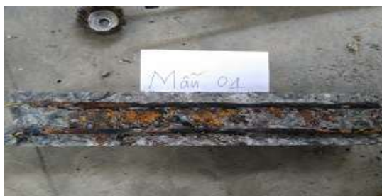
Hình 9. Cốt thép dầm bị ăn mòn sau khi thí nghiệm
