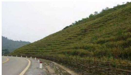
Hình. 3. Vetiver trồng trên taluy đường ở tuyến đường Hồ Chí Minh [4]
