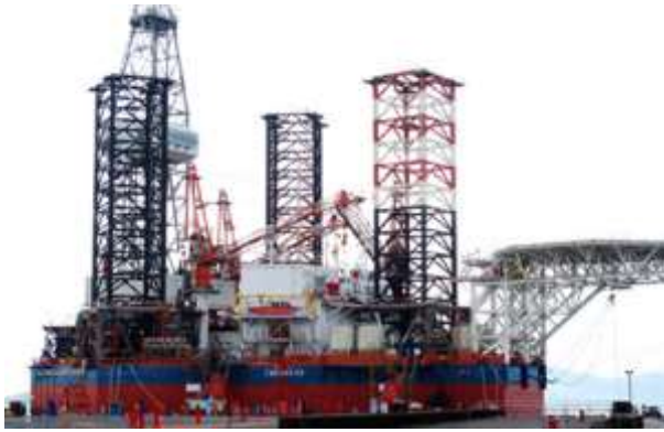
Hình 1. Giàn khoan tự nâng Tam Đảo 03 được chế tạo tại Việt Nam
